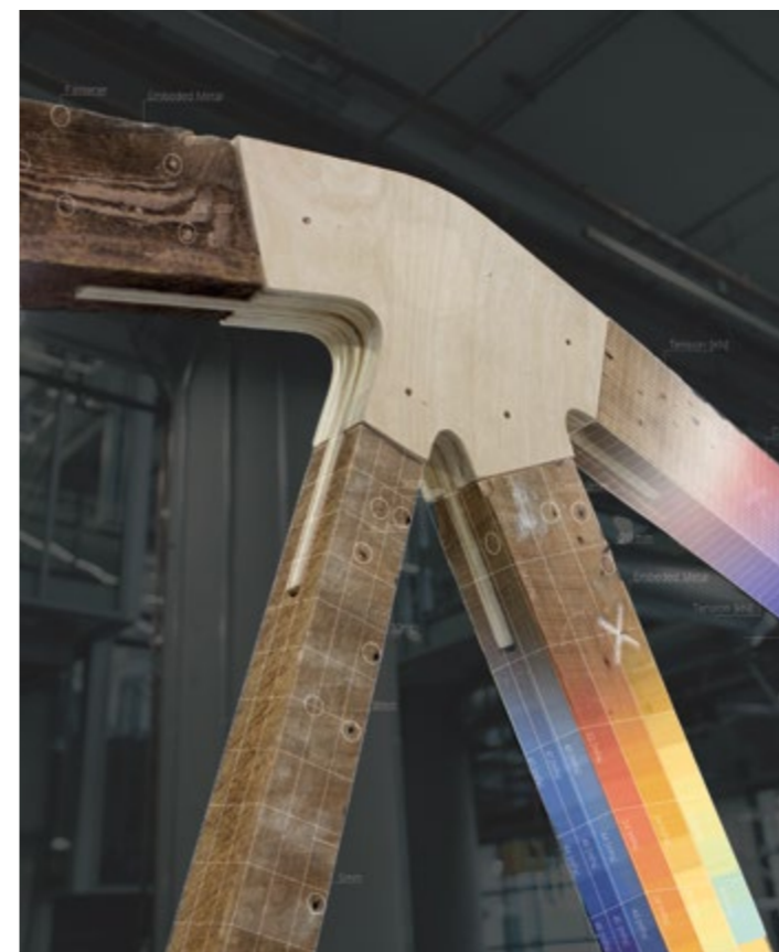
Darstellung des Materialgradienten am gebauten Fachwerk Demonstrator aus wiederverwertetem Holz.
